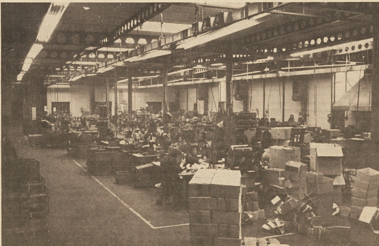
Montaža tovarne brni v delovnem vzdušju.
