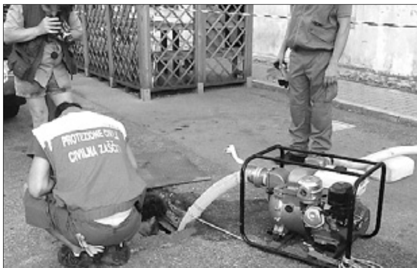
Črpanje vode z motorno črpalko iz podzemne cisterne
