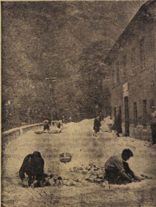
Kmalu se bomo skozi Bevško že peljali po novi cesti. Dela v zvezi z modernizacijo ceste so v polnem teku; v soboto so vozila že prvič zapeljala po delu novega cestišča
