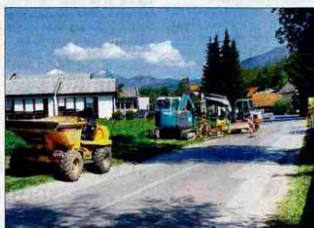
Ta teden se je začela tudi gradnja pločnika od vrtca v Komendi do Kralja v Mostah.
