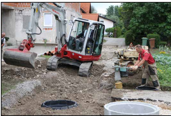
Pri gradnji kanalizacijskega omrežja v Parižljah
