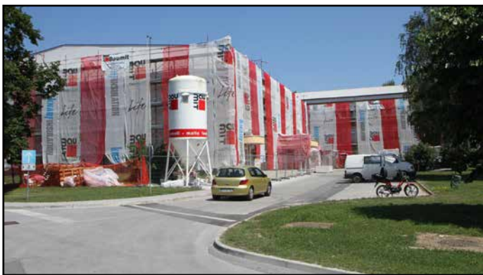
Energetska obnova OŠ Šempeter
