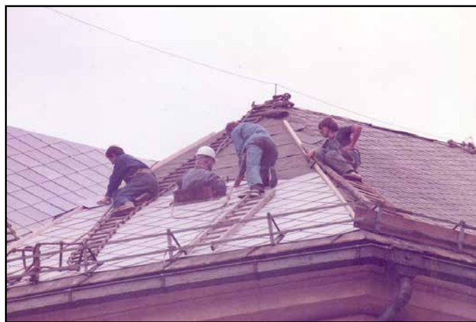
Za nevarno delo na cerkveni strehi sta se patra Viktor in Jože ustrezno usposobila.
