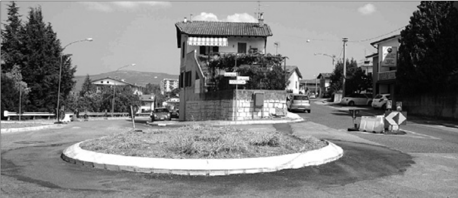
Na levi strani krožišča gredica nevarno štrli proti sredini cestišča in ovira prehod avtomobilov
