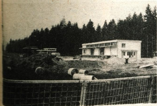
SKLADIŠČE IN TRGOVINA — Delavci kranjskega Gradbinca, TOZD Ljubljana končujejo z deli pri graditvi skladišča olj in maziv koprškega Istra-benza ob cesti I. reda Ljubljana-Kranj. Poleg objekta, ki bo imel 5 milijonov dinarjev, bodo uredili tudi trgovino z različnimi deli in tako ustregli številnim kupcem. (fr)
