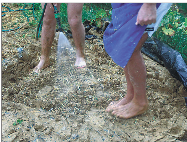
Tako pa izgleda mešalec na nožni pogon, ki dela tudi brez elektrike.
