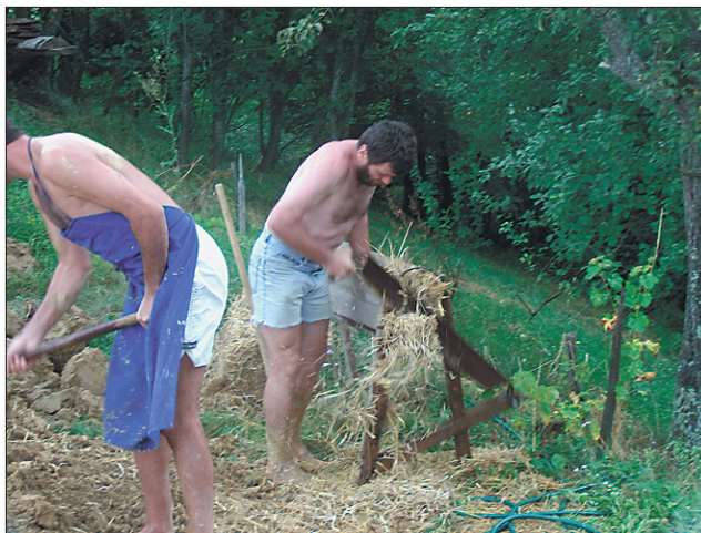
Za pravo fasadno mešanico je treba k blatu dodati narezano slamo.
