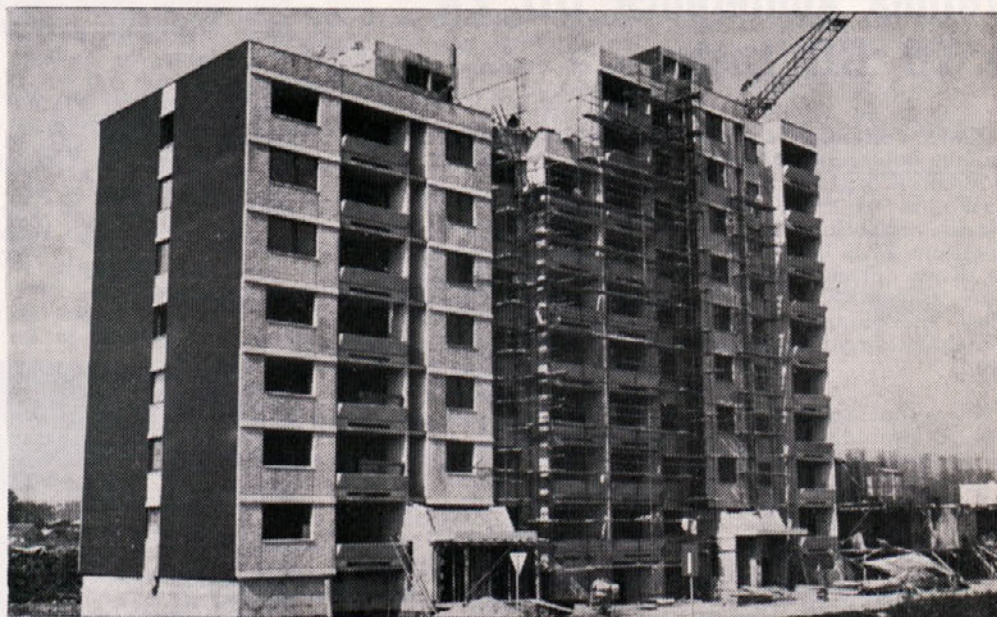
Stanovanjski verižni blok v Novi vasi v gradnji
