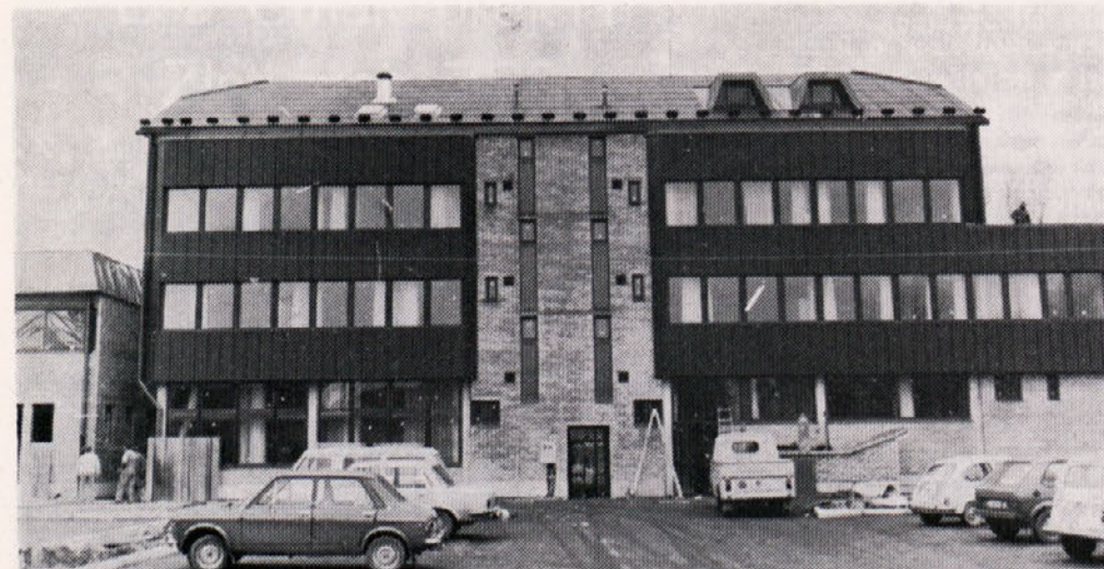
V teh dneh so delavci TOZD GO Šentjur hiteli z zaključnimi deli na objektu za Skupščino občine Šentjur
