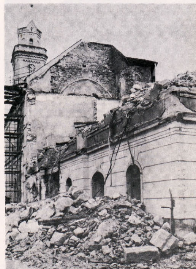
Rušitvena dela na Trgu V. kongresa opravljajo delavci TOZD GO Celje
