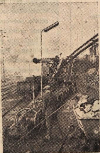
Dela za gradnjo opekarnе zidakov iz odpadnega materiala
