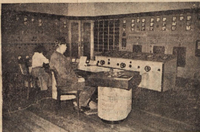
Razdeljevalnica električne energije
