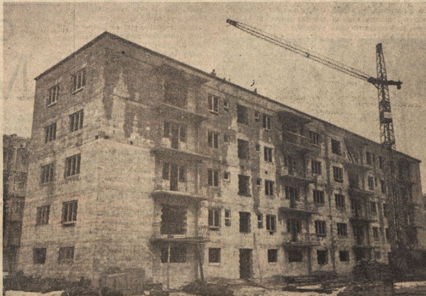
Stanovanjski blok v Zagorju, grajen po brigadnem sistemu, spredaj veliki žerjav, ki je bil dragocena pomoč
