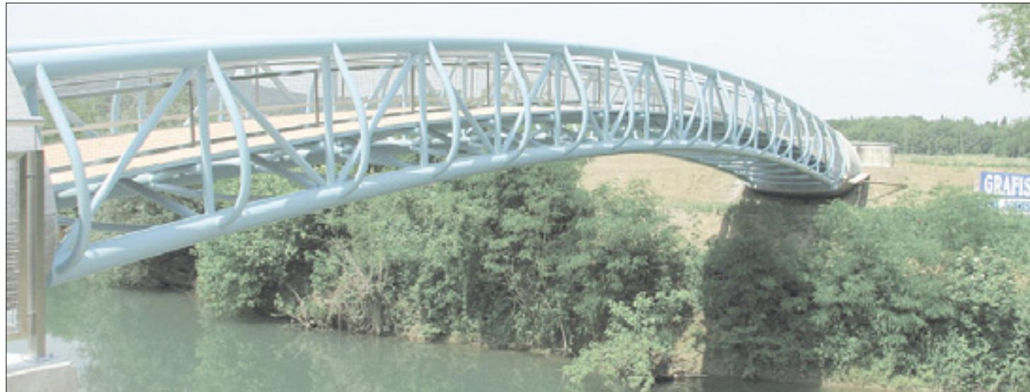
Novi mostič čez Vrtojbito; v eni izmed cevi jeklene konstrukcije je vgrajena tlačna kanalizacijska cev
