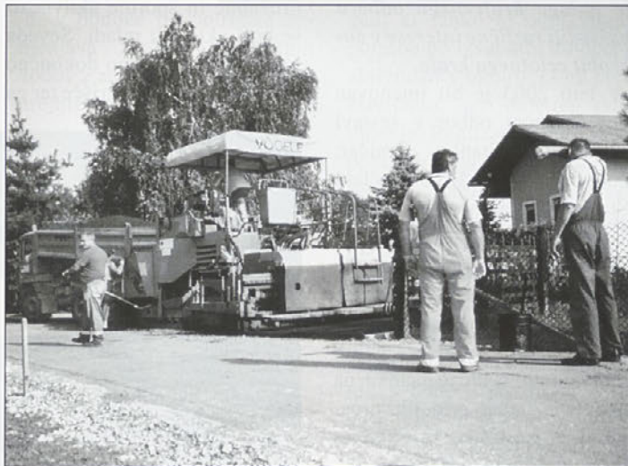
Prvi metri asfalta
