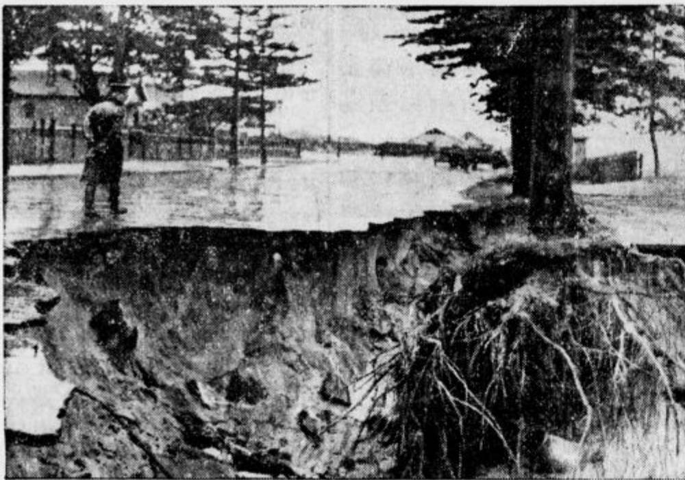
Tudi Avstralija je bila deležna silnega deževja, ki so mu sledile povodnji. Ker je cele dneve tako lilo, ni čuda, če je tudi povodenj bila nenavadno velika. Na sliki vidimo betonsko cesto, ki jo je narasla voda tako razdejala, da je raznesla betonsko ploščo na cesti.
