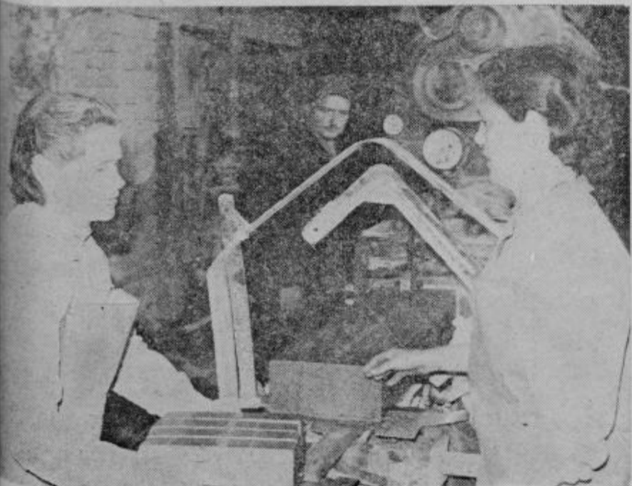
Na dva in pol milijona opečnih enot naredijo delavci v MIK-ovi opekarni, ki so jo letos rekonstruirali.
