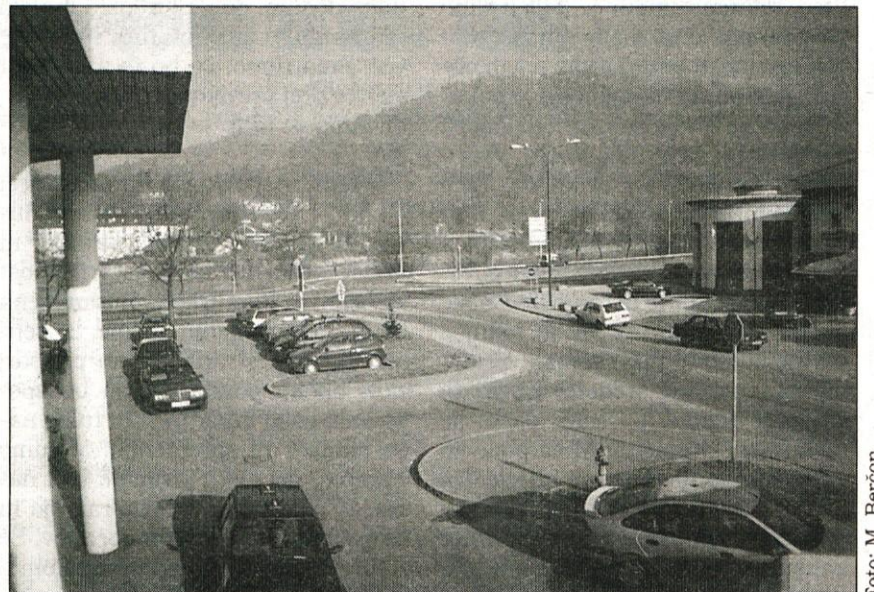
Novozgrajeno križišče je končno tudi semaforizirano. Upamo, da bo to prispevalo k večji prometni varnosti na tem delu cestišča.
