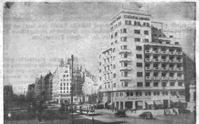
Bratianova cesta v Bukarešti, ki je bila močno poškodovana
