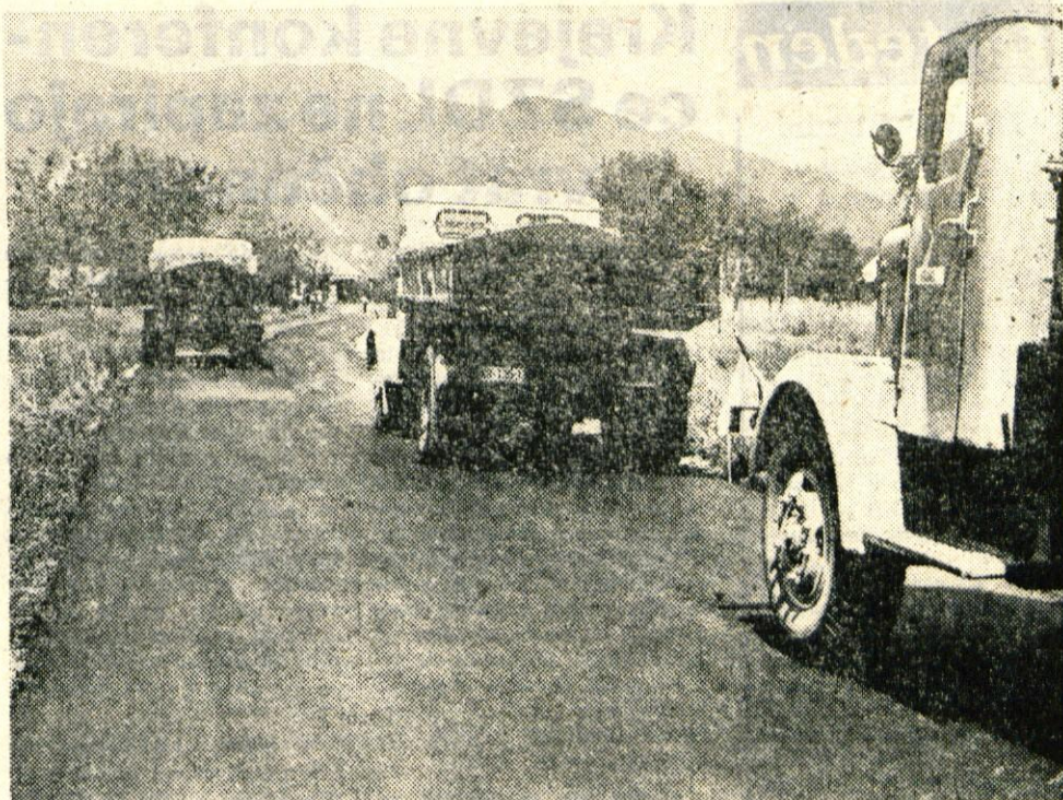
Delavci Cestnega podjetja iz Kranja so začeli pred kratkim asfaltirati cesto Križe—Zadraga, ki je bila v izredno slabem stanju. Cestišče bodo prekrili s 5 centimetrov debelo asfaltno plastjo. Denar za asfaltiranje je dala tržiška občinska skupščina, ki se je že odločila, da bo financirala tudi asfaltiranje ceste od križišča na Bistrici do Smoleja. (Jk) — Foto: F. Perdan
