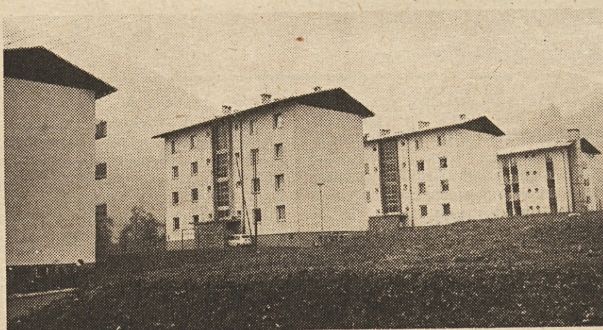
Na Kresu v Železnikih je v nekaj zadnjih letih zraslo novo stanovanjsko naselje. Tu je vrsta sodobnih blokov in zasebnih hiš, v njih pa prebiva dobršen del članov kolektiva naše tovarne v Železnikih.
