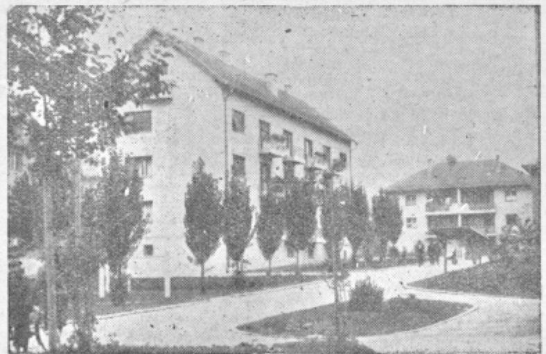
Novo stanovanjsko naselje v Šoštanju
