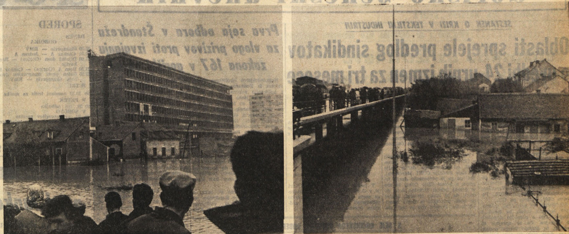
Kakor poročamo obširneje na 1. strani, je stanje v Zagrebu še vedno kritično. Vodovje Save je zalilo vse nižje predele mesta, od koder so se morali prebivalci izseliti. Tudi vsa pomoč tovarniških kolektivov, meščanov in vojske ne more veliko zaleči proti elementarnim silam, posebno, ker še vedno dežuje.
