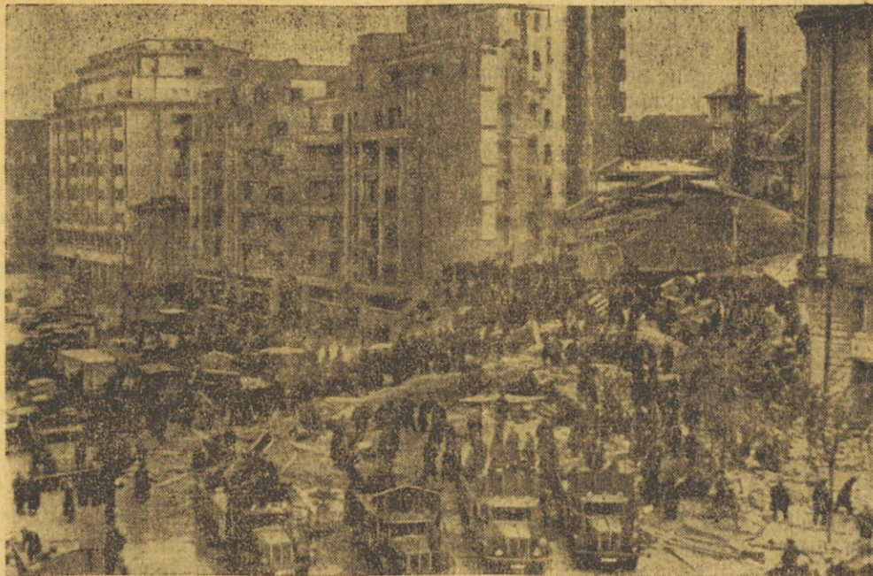
Am frühen Morgen des 10. November 1940 wurde die rumänische Hauptstadt von einem starken Erdbeben heimgesucht. — Unser Bild zeigt Aufräumarbeiten am Carlton-Haus in Bukarest unmittelbar nach dem Erdbebenstoß. Der eine Flügel des Wohnhauses ist vollkommen zusammengefallen
