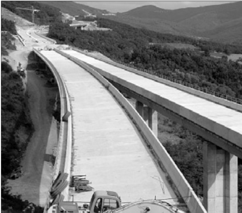
Gradbišče na nedokončanem odseku hitre ceste prek Rebernice
