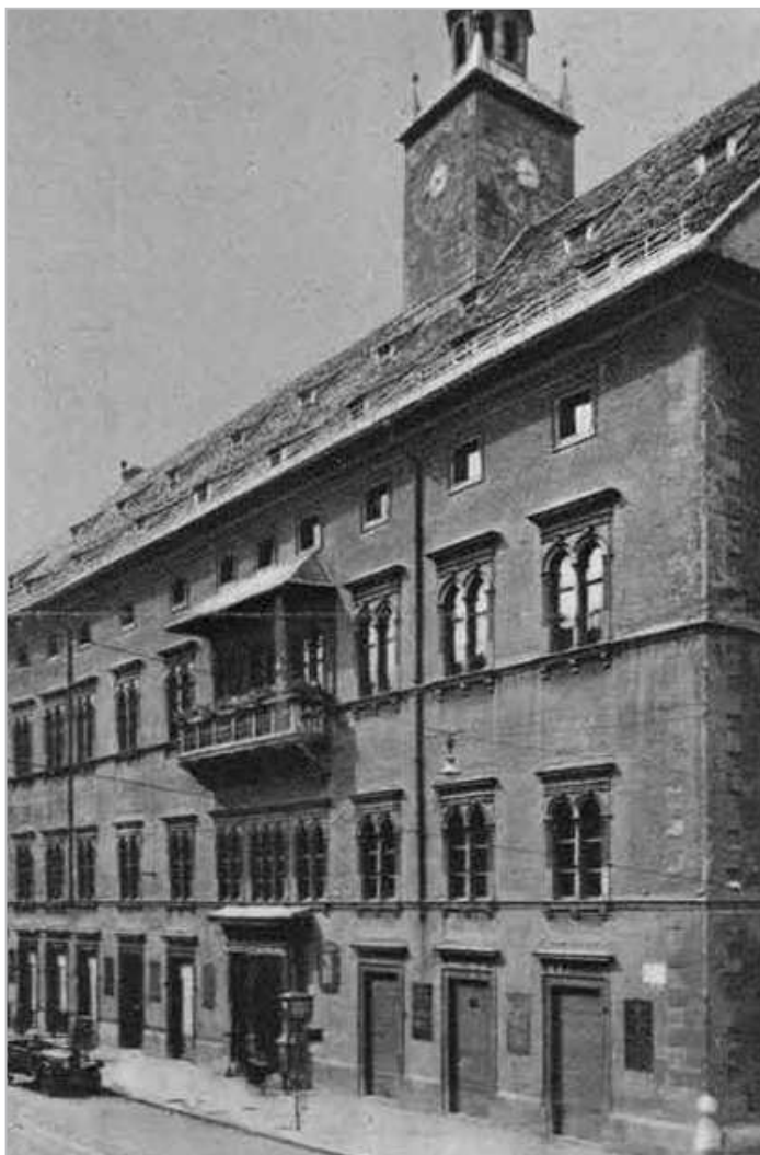
Dvorec štajerskega deželnega zbora v Gradcu ("12. V. 1872 • 1932", Ilustrirani Slovenec , 8. 5. 1932, št. 19, str. 78)
