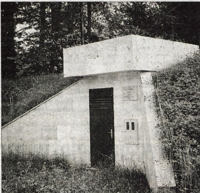
Lani zgrajeni zbiralnik na Brdu čaka na vodo iz doline.
