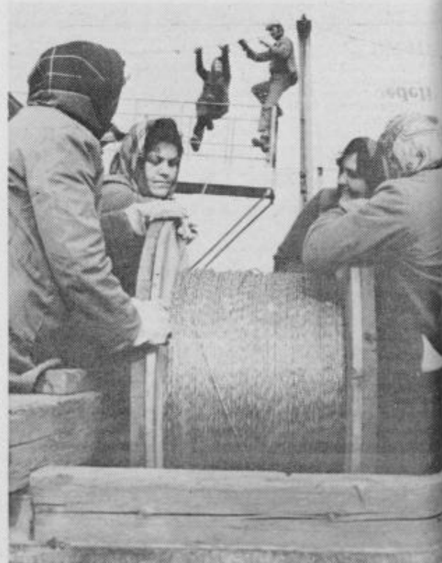
Tone Tavčar: Pričela se je obnova hmeljskih žičnic.
