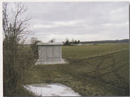
Ob bodoči industrijski coni v Moškanjcih je že postavljena nova transformatorska postaja.
