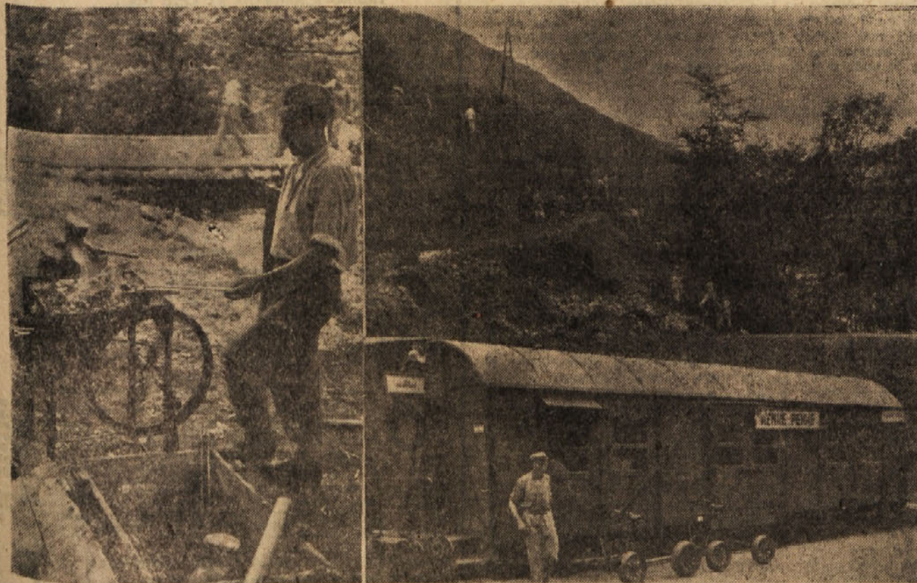
BULDOZERJI RIJEJO, KRAMPI POJEJO, MLADE MOČNE ROKE BORCEV JLA PA OSVAJAJO METER ZA METROM PRI DELIH NA ZASAVSKI CESTI. LETOSNI DAN VSTAJE BODO TUDI TI PRAZNOVALI Z DELOVNIMI ZMAGAMI NA TEM VAŽNEM OBJEKTU - KAR PO DOMAČE SO SI UREDILI KOVAČNICE, LEPI JE POGLED NA SAVSKO SOTESKO, KJER BO SE LETOS OD PASJEKA DO TOLMUNOV NAREJENA CESTA - IN SE NA NEKAJ BO TREBA MISLITI VZPOREDNO Z GRADNJO CESTE! DA SE UREDI TUDI POSTAJALIŠČE V RENKAH ZA SEDAJ JE SE V REDU, KO BO PA ZGRAJENA ZASAVSKA CESTA, BO TREBA UREDITI TUDI TO VPRASANJE.
