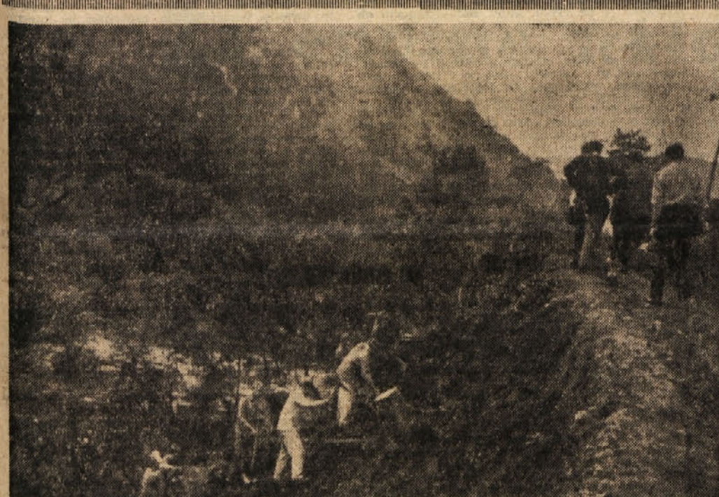
PRAV POSTENO SO ZAGRABILI NASI BORCI PRI GRADNJI ZA SAVSKE CESTE
