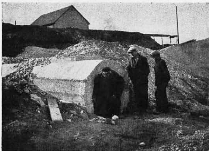
Tak je vhod v kanal v Vilharjevi ulici
