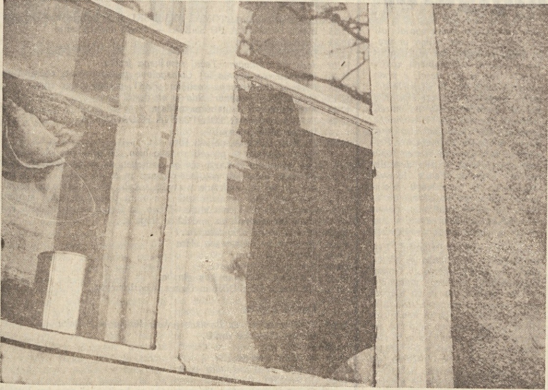
Razbita šipa okna prosekne osnovne šole
