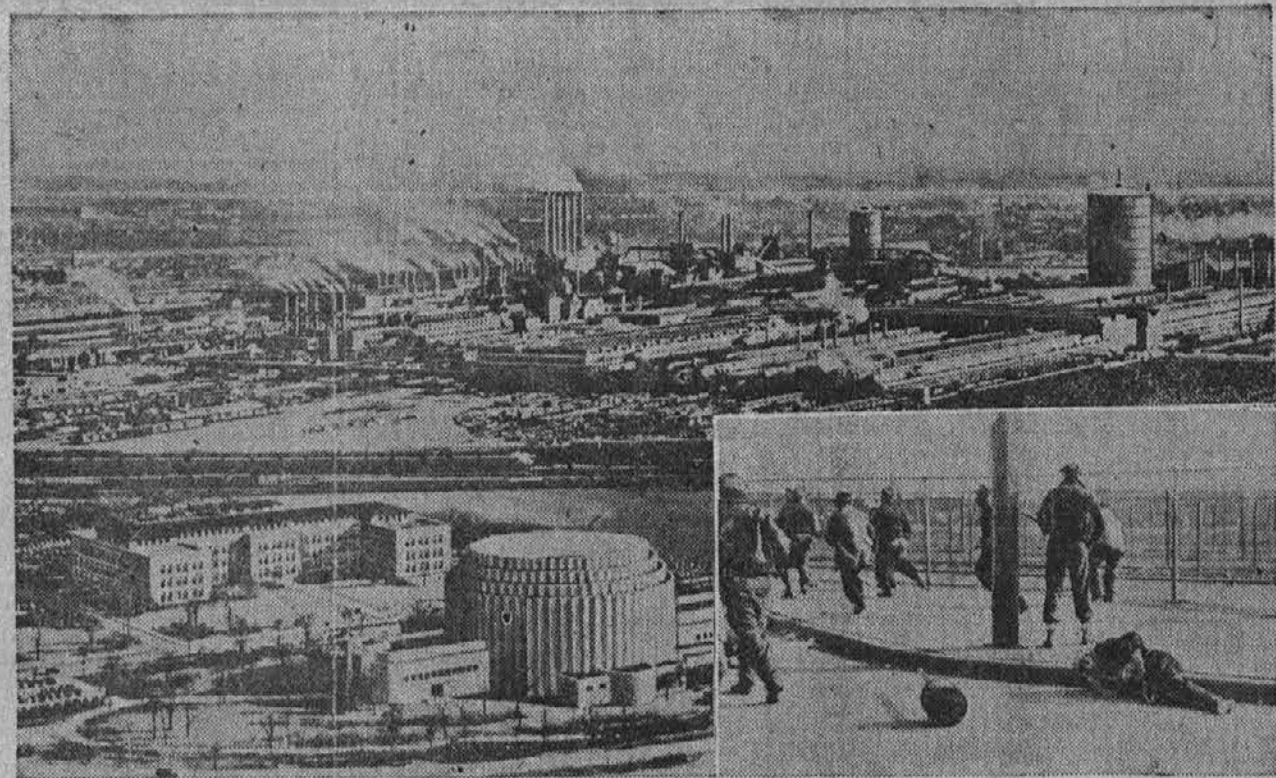
Na sliki vidimo Fordovo tovarno v River Rouge pri Dearbornu, Mich., največjo industrijsko tovarno na svetu, kjer se je vršil nedavno štrajk. Tovarna zaposluje 85.000 delavcev. V desnem kotu vidimo prizor, ko je neki stavar baš padel na tla, zadet po krogli, ki je od nekod prifrčala.
