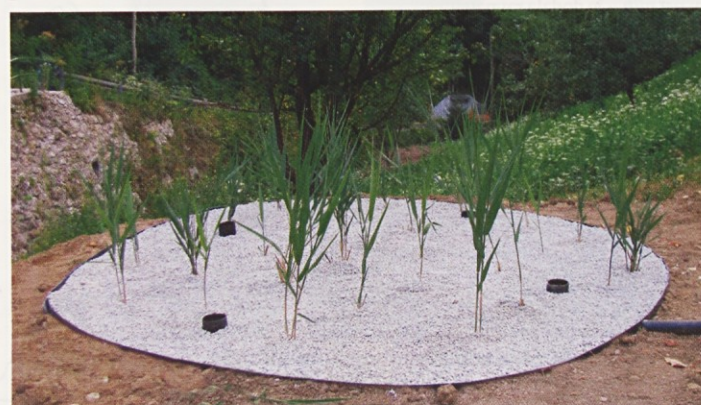
Rastlinska čistilna naprava.
