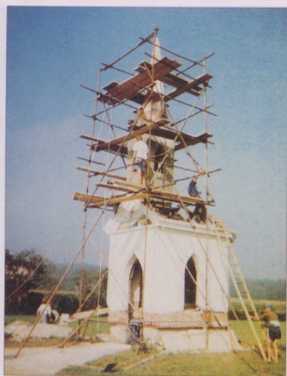
Obnova kapele v Dobravi
