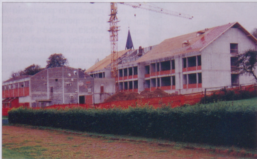
Gradnja osnovne šole pri sv. Juriju v Prekmurju
