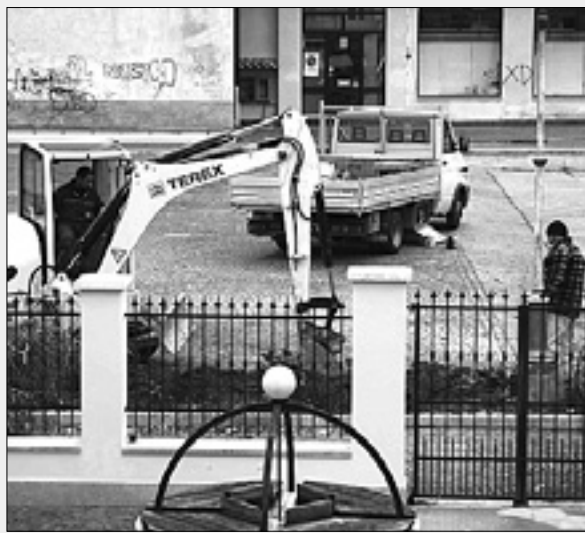
Dela na ploščadi med ulicama De Gasperi in Morelli, v goriškem mestnem središču
