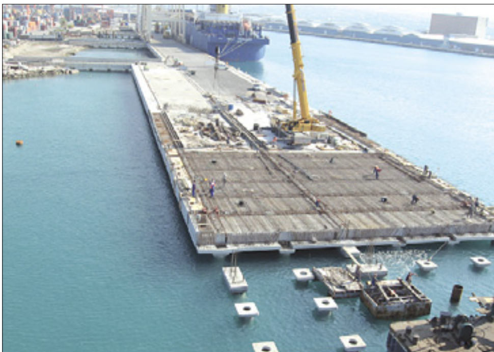
Gradnja kontejnerskega pomola v koprskem pristanišču
