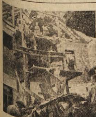
Frostovoljci pri gradnji šole v Nevljah pri Kamniku
