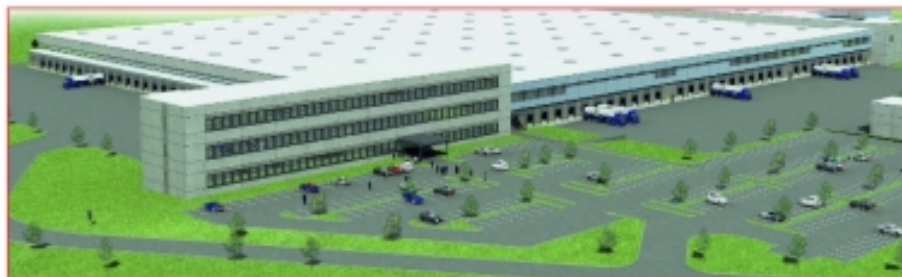
Hoferjev nov logistično-distribucijski center na Prevojah v občini Lukovica
