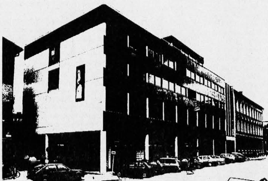
Pročelje »Slomškovega doma« (na levo) v Celovcu, kjer bo v drugem nadstropju dvojezična osnovna šola za koroške Slovence
