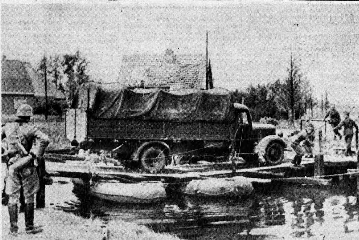
Nemški vojaki vozijo vojni material čez zasilni most iz gumijastih čolnov čez neki prekop na Nizozemskem.
