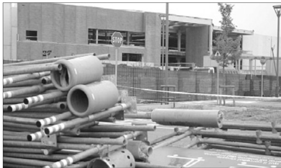
Gradbišče novega nakupovalnega središča
