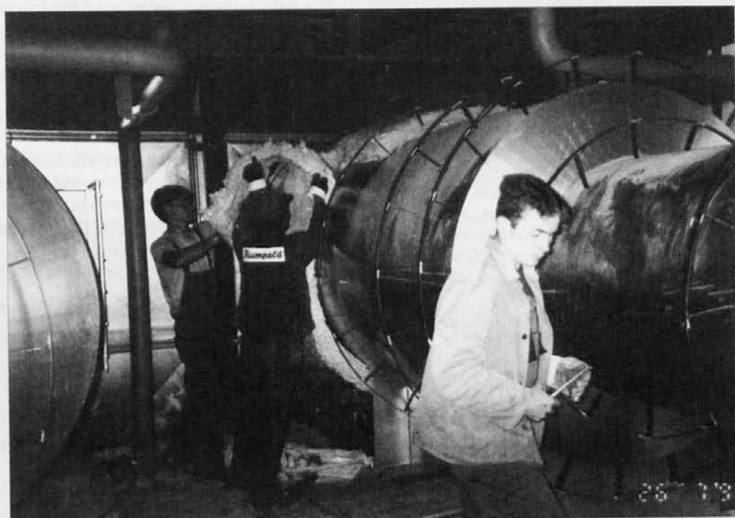
Tako so julija potekala izolacijska dela na glušnikih. (Foto: Miran Fužir)
