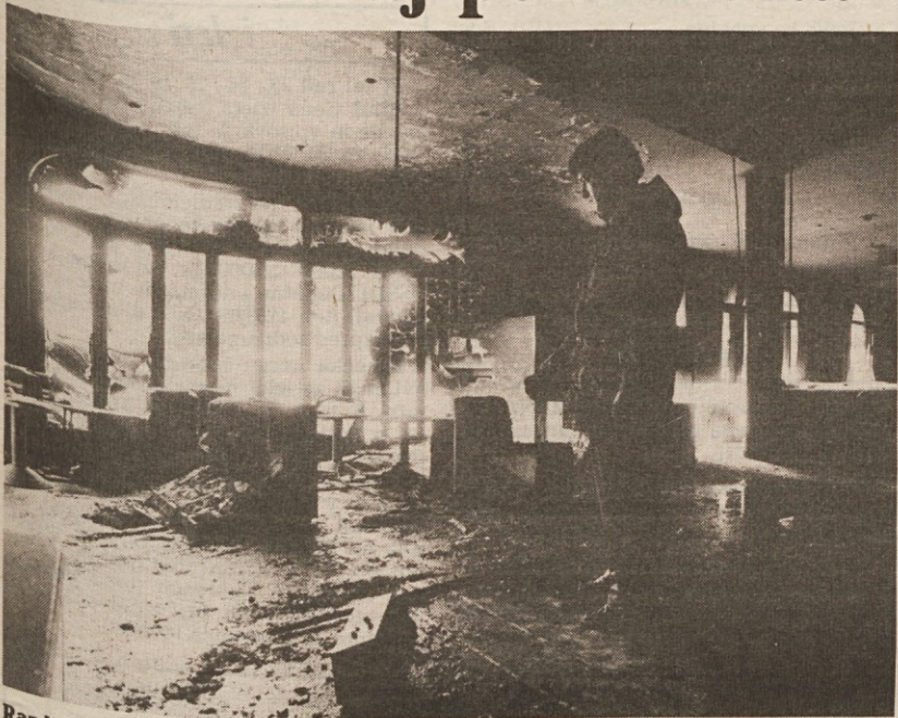
Razdejana notranjost grljanskega diskokluba po nočnem požaru. Hiter poseg gasilcev pa je v precejšnji meri omejil škodo.
