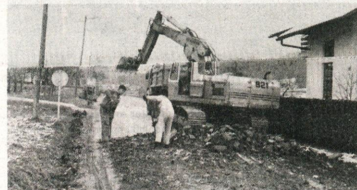
Cesta med gradnjo
