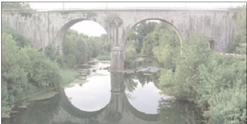
Pogled na železniški most in strugo v Sovodnjah s cestnega mostu proti Petovljani
