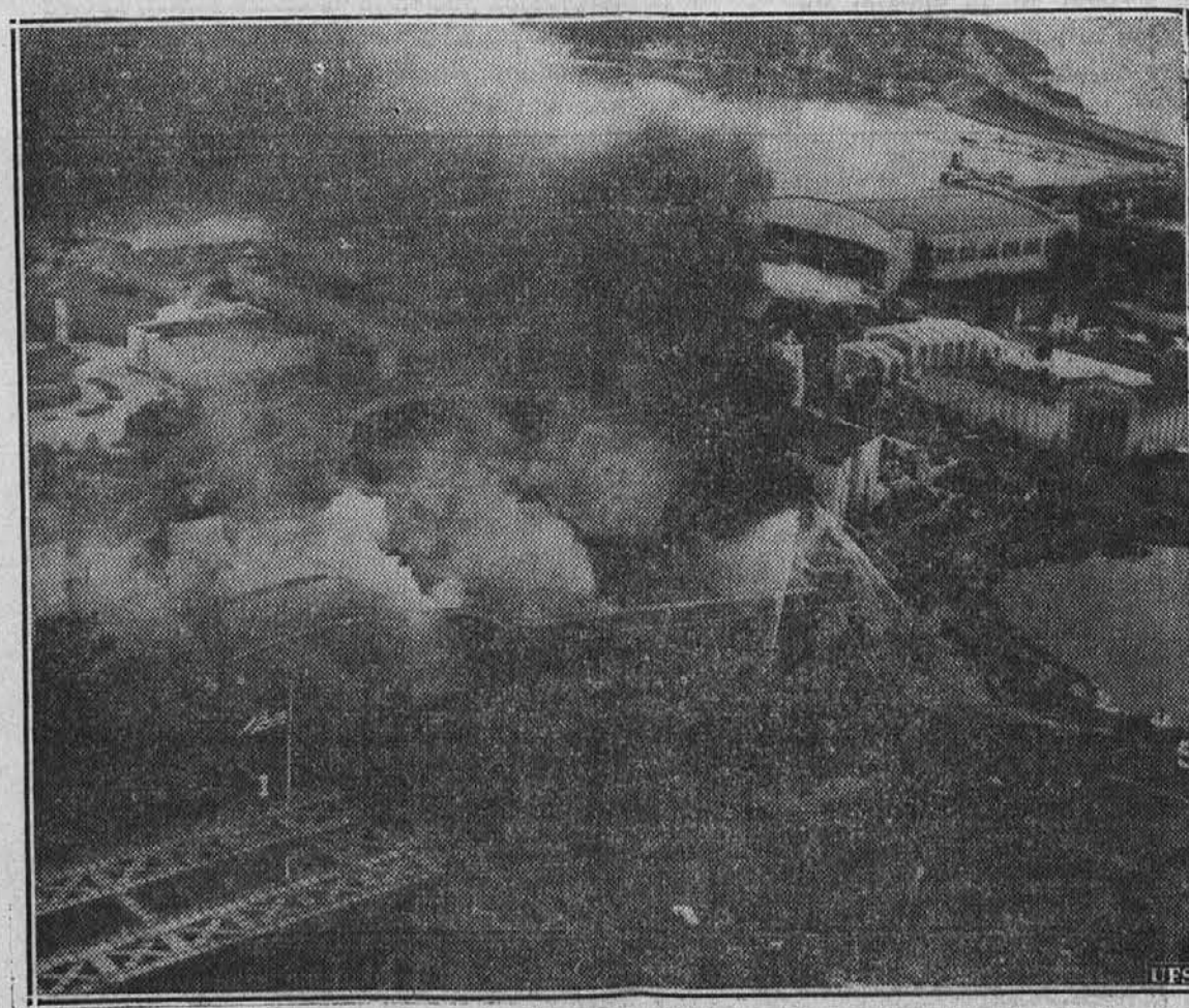
Slika nam kaže prizor iz Golden Gate mednarodne razstave, ko je izbruhnil požar v Californiji poslopju. Požar je napravil krog $400,000 škodo. Posrečilo se je, da so reši- li najdragocenejše predmete. Junaškim gasilec gre zasluga, da se požar ni raztegnil še na druga poslopja.
