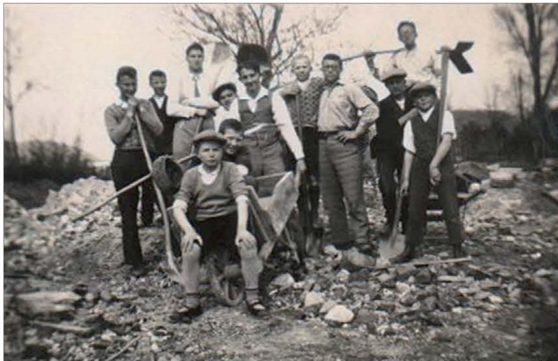
"Delavci: popravljali smo igrišče". Malo semenišče v Gorici, 7. 4. 1932. Klinec drži samokolnico. Na samokolnici sta Sluga Ludvik in Štegel. Levo od Klineca: Ličen, Špacapan, Černigoj, Šatej. Desno od Klineca: Kos, Kogoj, Srebrnič, Kragelj. Zada: Kenda.
