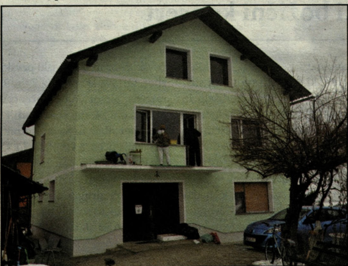
Hiša po ureditvi izolacije in fasade
