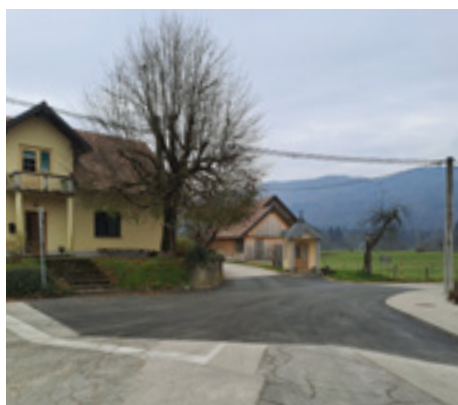
Asfaltiranje ceste Pri Cerkvi
