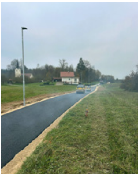
Asfaltiranje ceste proti Podgorici
