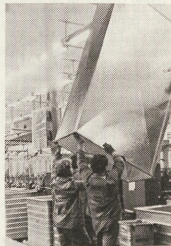
Delavci IMP montirajo nove klimatske naprave v predilnici 2.
