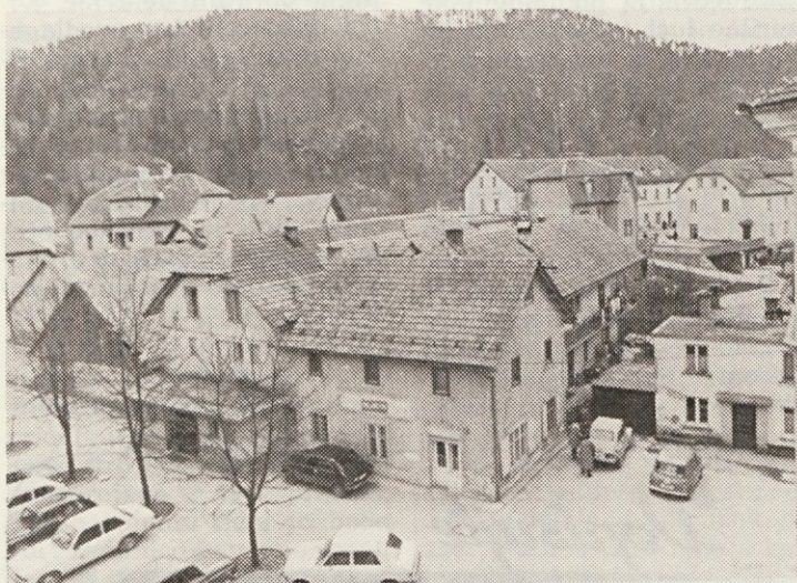
Zgradbe okoli bivšega kina so zrele za rušenje, samo kako zagotoviti denar za novo zgradbo;
