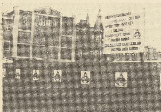
Nov objekt Supermarketa »Prehrane« v Mariboru — Pričetek gradnje
