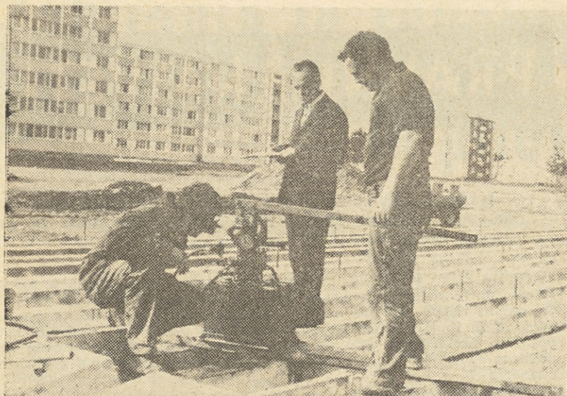
Pod določenim pritiskom brizgajo betonsko maso v odprtine prednapetega nosilca
