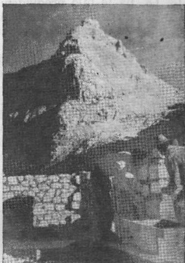
Zidarji pri delu. Julij 1951. Zadaž Razor
