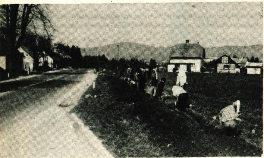
Godešič pri Škofji Loki — Mladi Godešani so preteklo soboto in nedeljo prišli za lopate in izkopali jarek za položitev kabla za krajevno javno razsvetljavo. Prostovoljnega dela so se člani osnovne organizacije ZSMS Godešič lotili na pobudo sveta krajevnih skupnosti. Izkopali so polovico predvidenih 430 metrov, zato bodo akcijo ponovili. O zavzetosti mladih Godešanov priča številna udeležba: v soboto je delalo kar 28 mladih fantov, v nedeljo jih je bilo le nekaj manj. — Foto: M. V.
